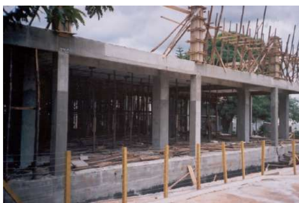
Instalação da 2ª laje do Centro Social
