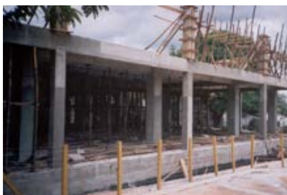
Instalação da 2ª laje do Centro Social
